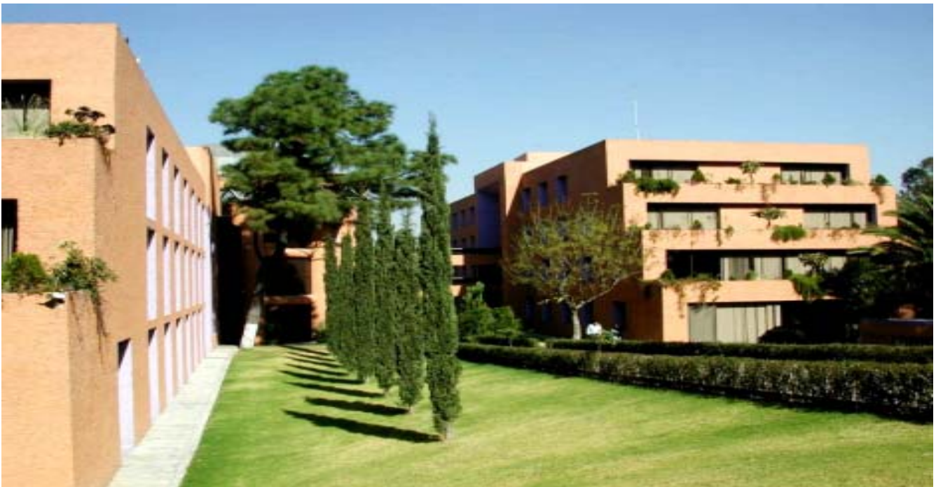
Edificio Principal de INAOE
